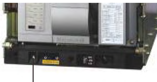
Механизм блокировки в отсоединенном положении
