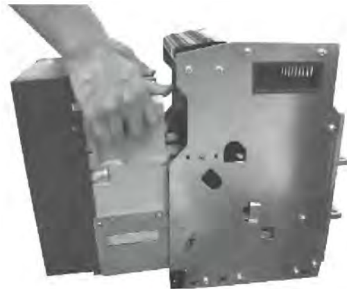
Рисунок 14 – Установка выключателя в корзину
